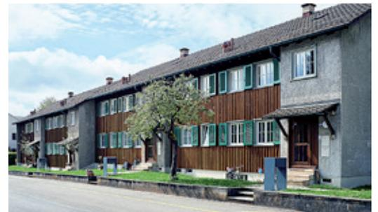
Strassenfassade einer Häuserreihe nach der Sanierung mit wiederhergestellter vertikaler Holzschalung nach bauzeitlichem Vorbild, 2023
