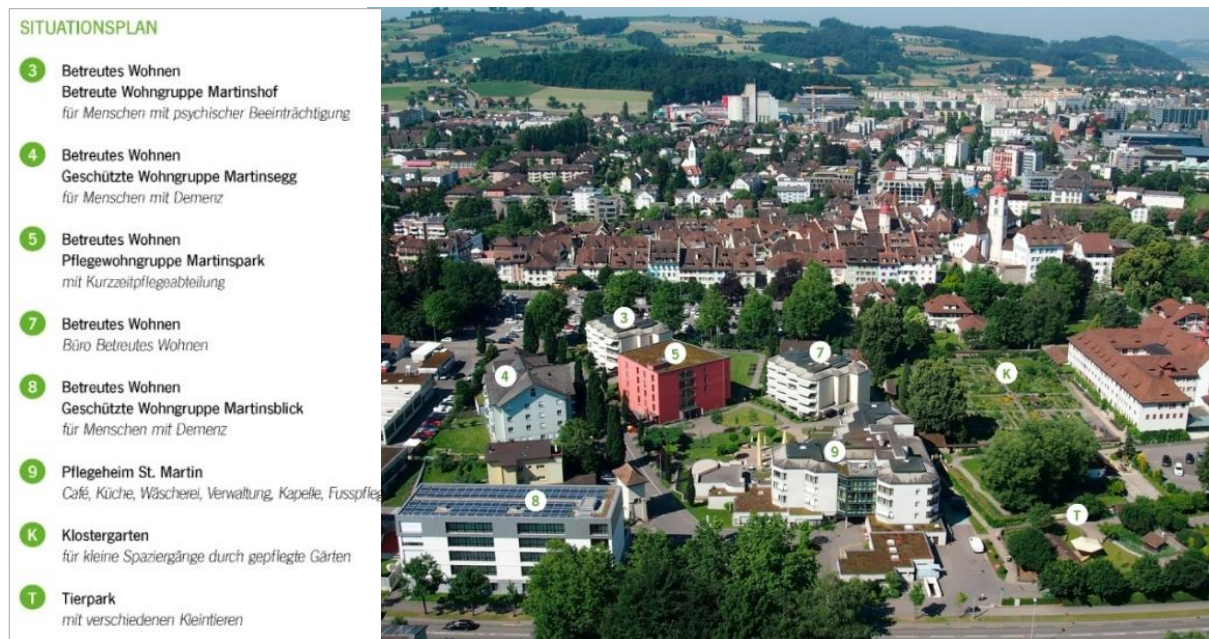
Abb. 1: Luftbild der Anlage AltersZentrum St. Martin mit den dazugehörigen Bauten und Aussenanlagen (Quelle: AZ St. Martin Sursee)
