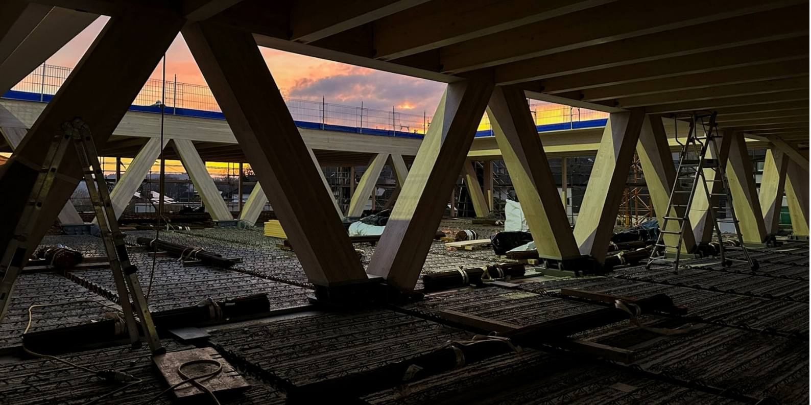
Neubau Doppelturnhalle und Musikschule, Rombach
