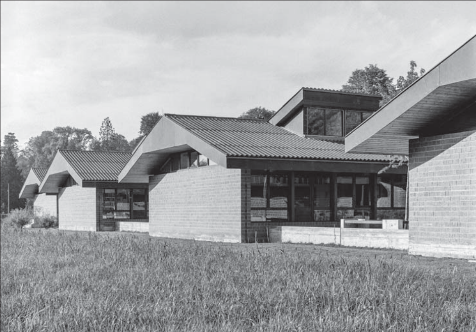
Pavillonschule Hellmatt in Möriken-Wildegg, Ansicht von Süden, 1. Etappe (Foto: Werner Erne)
