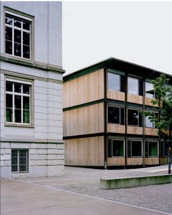
Die Züri-Modular-Pavillons ergänzen in der Regel ein bestehendes Schulhaus. Pavillon beim Schulhaus Hutten (Architektur: Bauart, Fotos: Rasmus Norlander)
