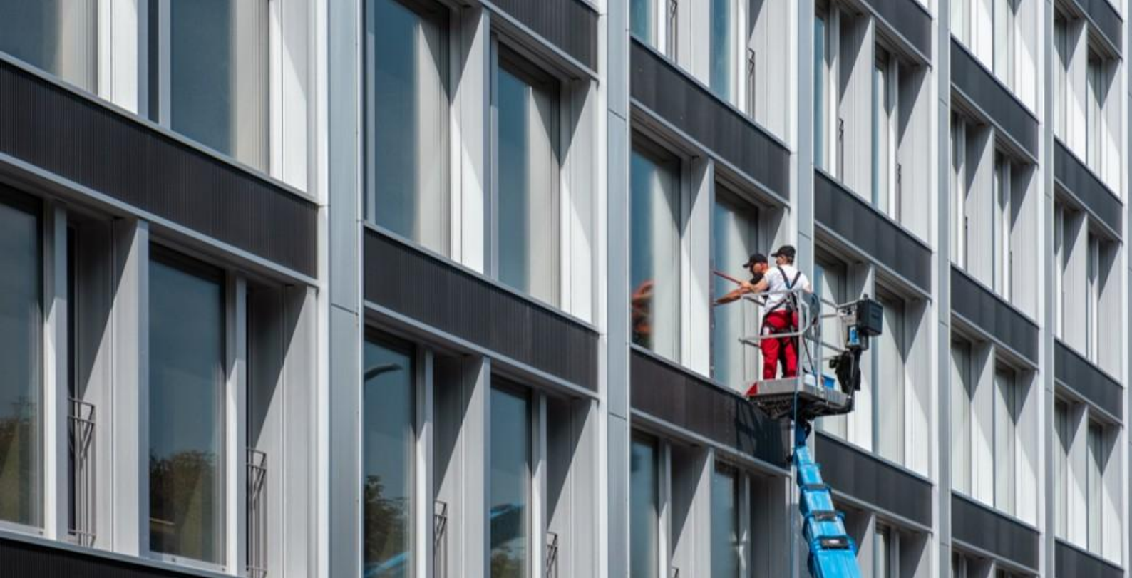
Gesamtinstandsetzung Zeughausstrasse, Zürich
